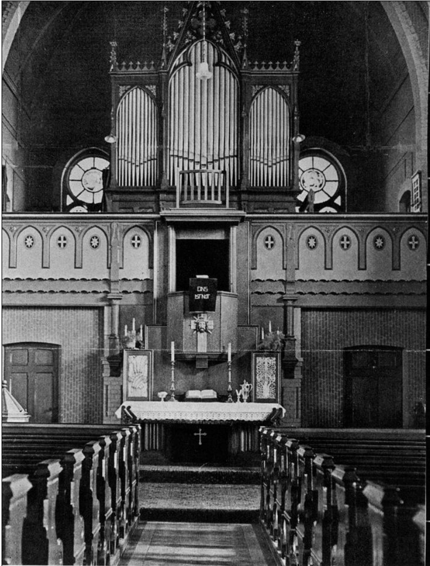
Innenraum nach Umbau 1928; der Kanzelzugang ist in die Emporenbrüstung integriert und erfolgt direkt von der Sakristei.
