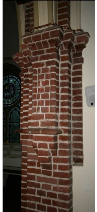
Kapitell eines Backstein-Pfeilers, oben in Konsolen mündend, als Auflager der Gewölbe-Gurtbögen.
