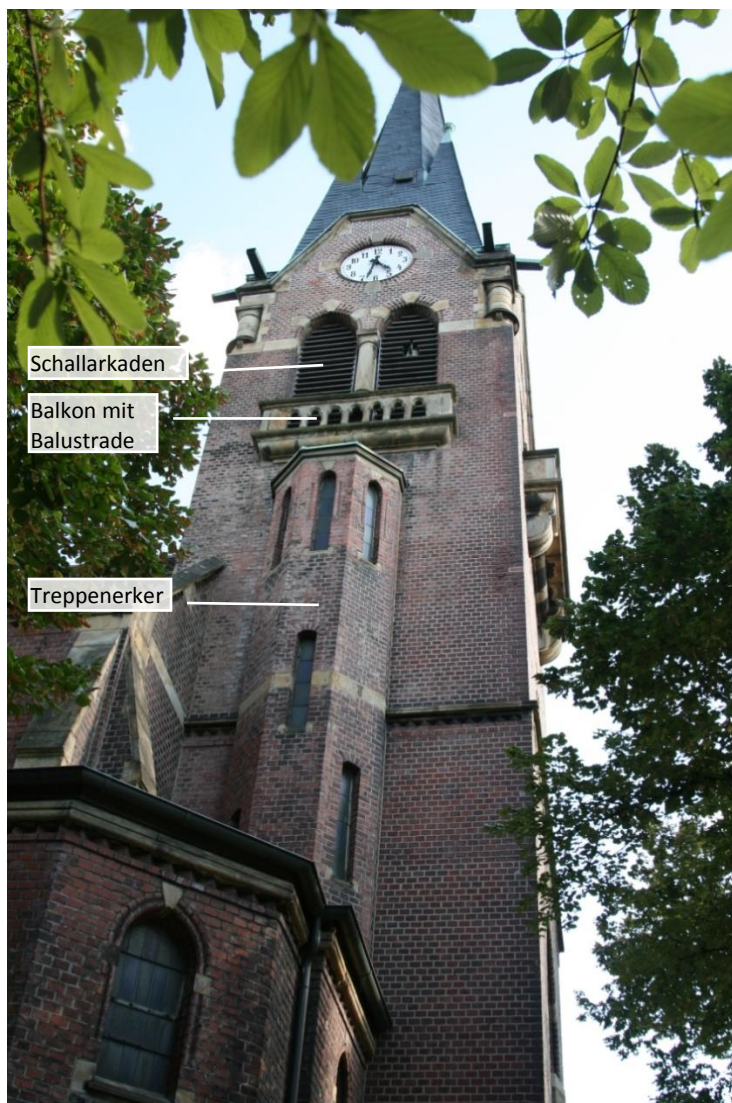
Turm von Norden. Treppenerker, Schallarkaden mit Balkon.
